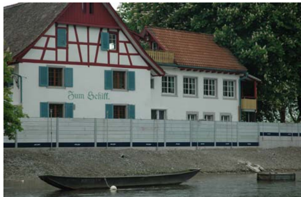
Abb. 4 Dammbalkensystem
