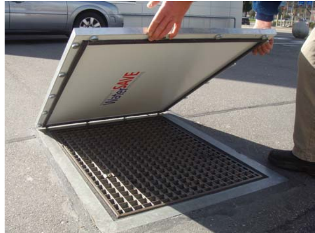
Abb. 2 Hochwasserschutz für Lüftungsschächten
